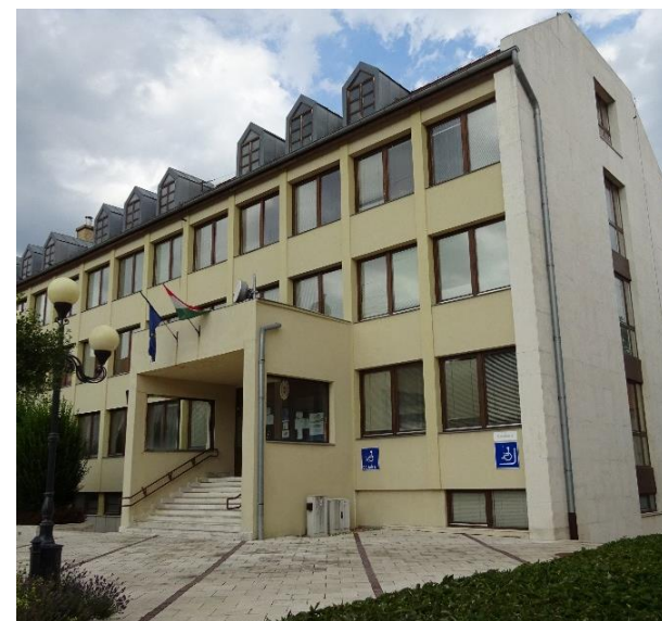
Egyszerű vakolt homlokzat, visszafogott színekkel
