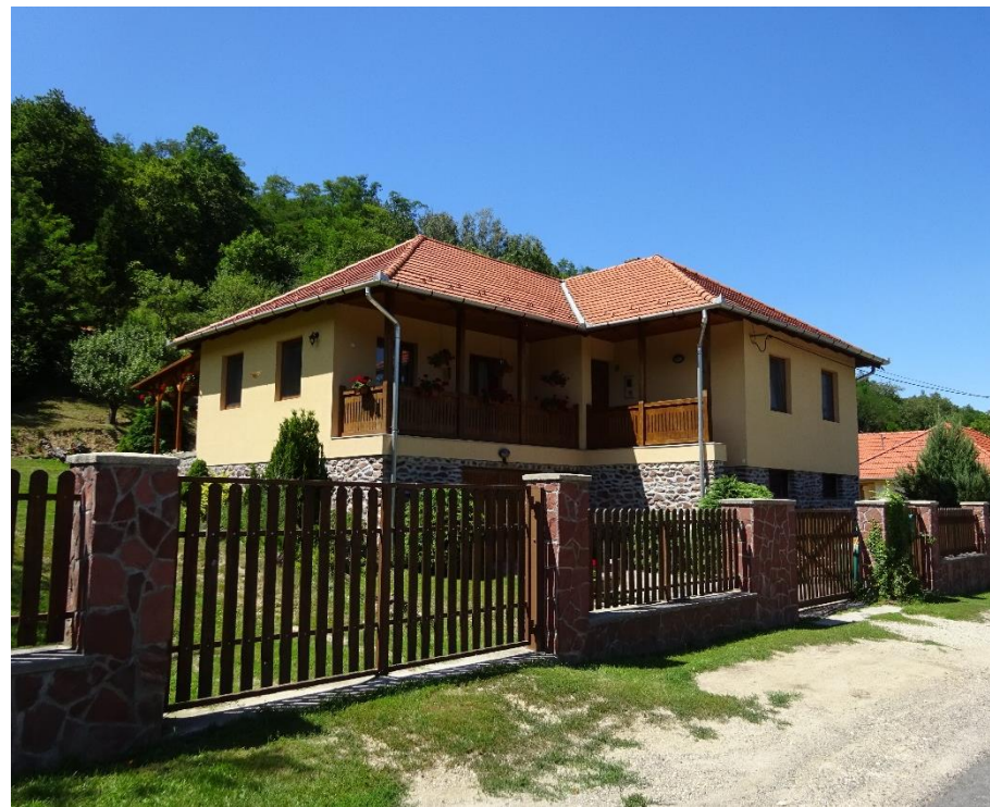
Földszint+egyszintes újépítésű családi ház a település bevezető útja mellett
