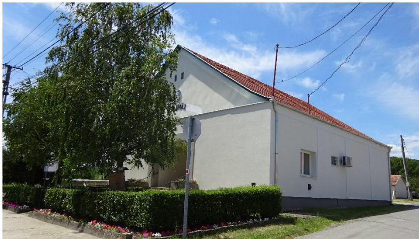
Faluház, sátortetővel, az épület előtt zöldsávval, virágkiültetéssel
