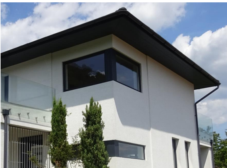
Homlokzatrészlet egy kortárs épületen antracitszínű ablakokkal
