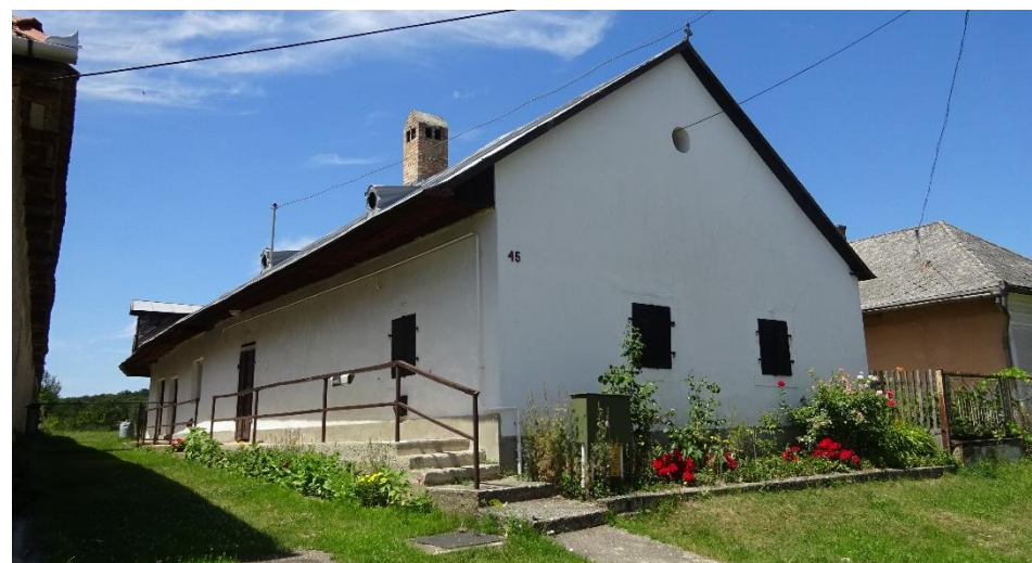
Régebb építésű magas oromzatú ház egyszerű vakolt homlokzattal, megőrizve az épület egyediségét
