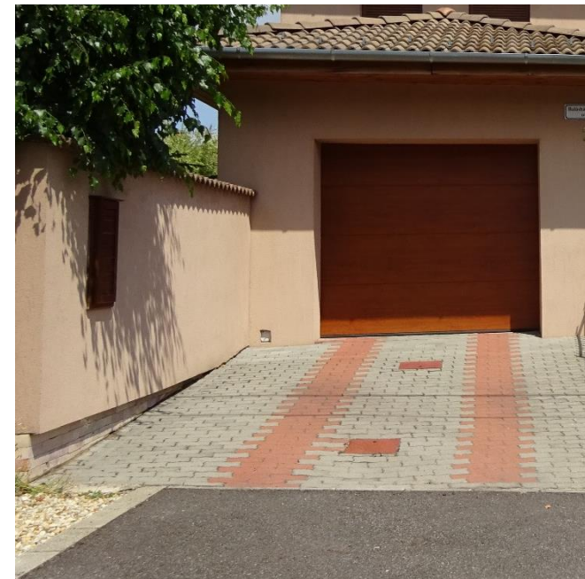
A kerítésfalba süllyesztett villanyóra szekrény nem zavaró, rejtve marad
