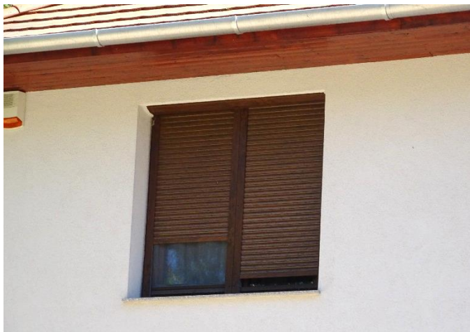
Rejtett kialakítású redőnytök az épület homlokzatához illő színben
