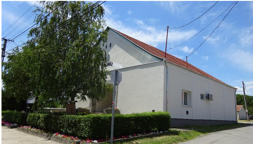
Faluház, sátortetővel, az épület előtt zöldsávval, virágkiültetéssel
