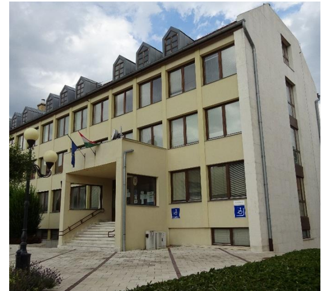
Egyszerű vakolt homlokzat, visszafogott színekkel
