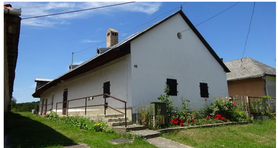
Régebb építésű magas oromzatú ház egyszerű vakolt homlokzattal, megőrizve az épület egyediségét
