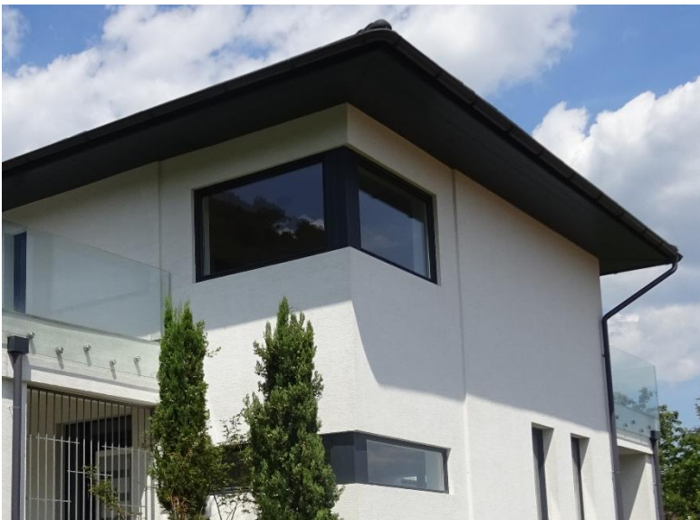
Homlokzatrészlet egy kortárs épületen antracitszínű ablakokkal
