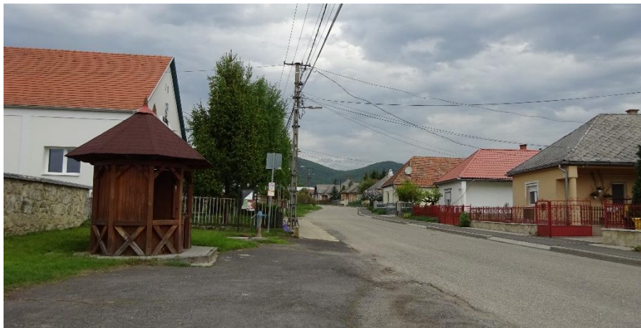
Hagyományos, kontyolt tetőformájú, földszintes házak a település főutcáján (jobb oldalon), bal oldalon a Községháza látható
