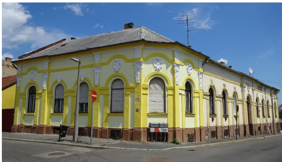
Díszes homlokzatú saroképület a Deák Ferenc utca-Posta köz sarkán
